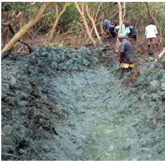
Die Fischgräten-Kanäle wurden verbessert, um den Wasserfluss zu optimieren und das Wachstum der Setzlinge zu unterstützen.
