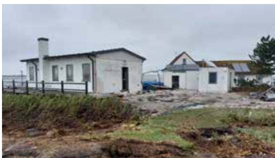
Der südliche Grundstücksbereich mit Giftbude (li) und Hafenmeisterei (re) unmittelbar nach der Sturmflut. Die Küchencontainer sind verdriftet und zerstört.
