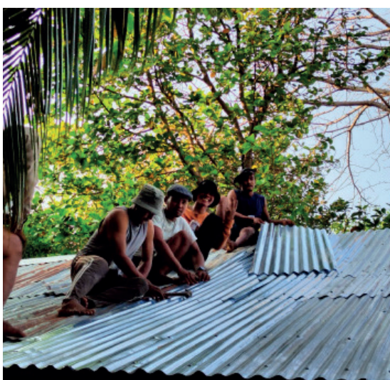
Die Reparatur und Verbesserung des Regenwasser-Sammel-systems konnte durchgeführt werden.
